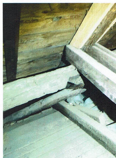
ZDJ. 14 Uszkodzenia zwiatrowania i elementów więzara
