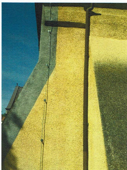
ZDJ. 3 Odspojenie przypory - elewacja wsch.
