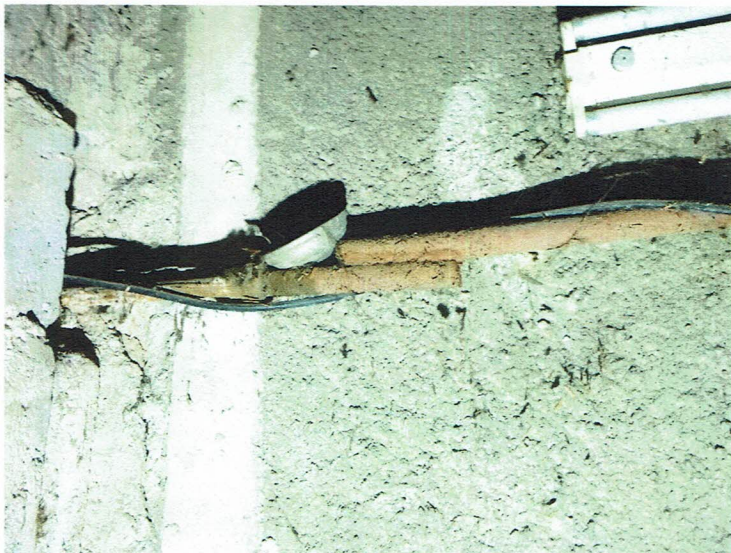
ZDJ. 15 Wadliwy sposób połączenia ściągów podłużnych strona północna
