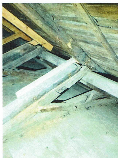
ZDJ. 13 Uszkodzenia więzów
